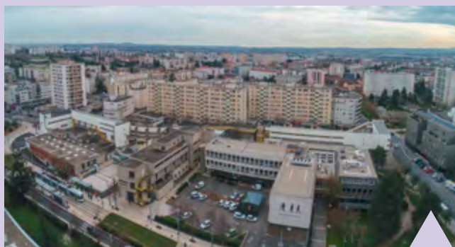
Nouveau Programme National de Renouvellement Urbain (NPNRU) de Bellevue : 1,4 M€ (exécution et acquisition).
