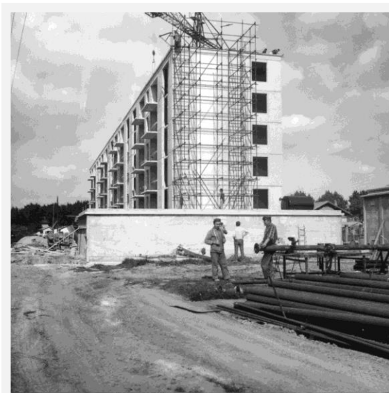
Construction de Bel Air I, 1968, AMSP
