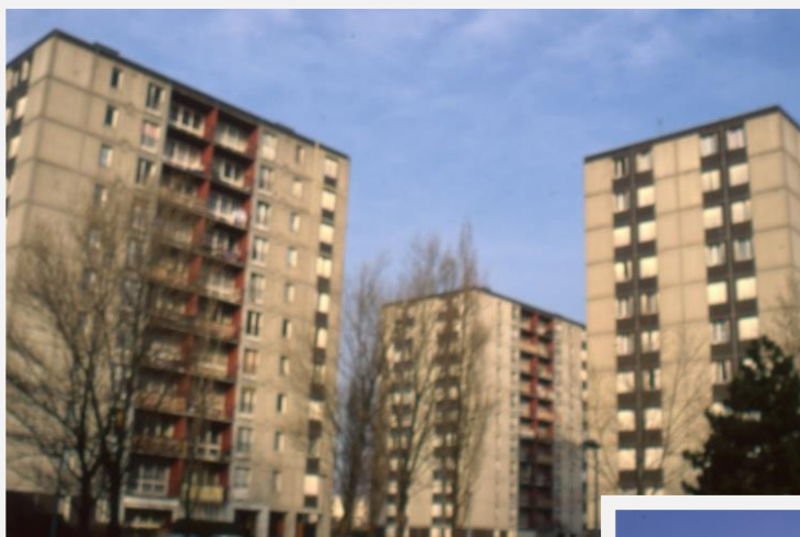
Les tours 105 et 106 avant réhabilitation, 1996, AMSP
