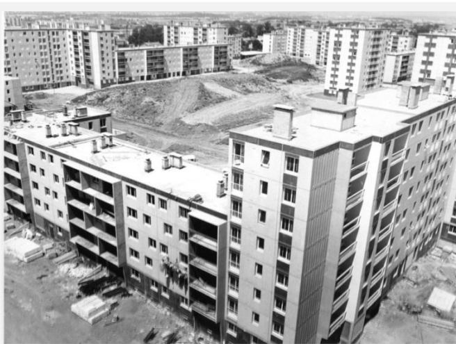
Construction de Bel -Air I, 1969, AMSP
