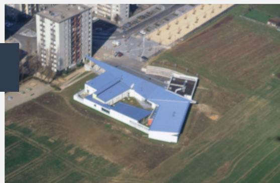
La nouvelle MJC vue du ciel, 1994, AMSP
