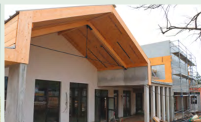
Construction du nouveau restaurant scolaire.
