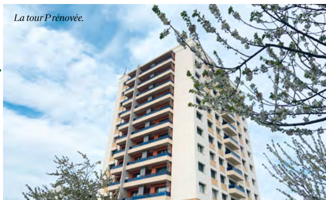
Rénovation en cours de l'immeuble F.
