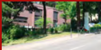
Des locaux refaits à neuf pour le centre social de La Carnière, qui a été ravagé par un incendie en 2010.
